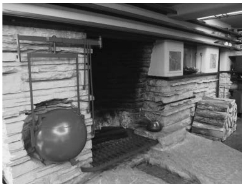
図 13 岩盤と一体となった暖炉。「落水荘」ができる前、カウフマン親子はこの岩盤の上で甲羅干しをしていた
