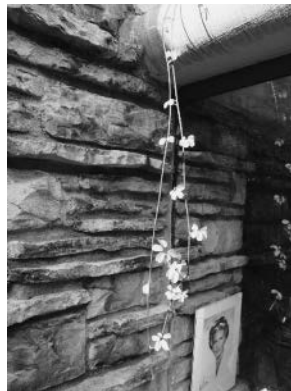
図 15 石とガラスをサッシ なしで接合
